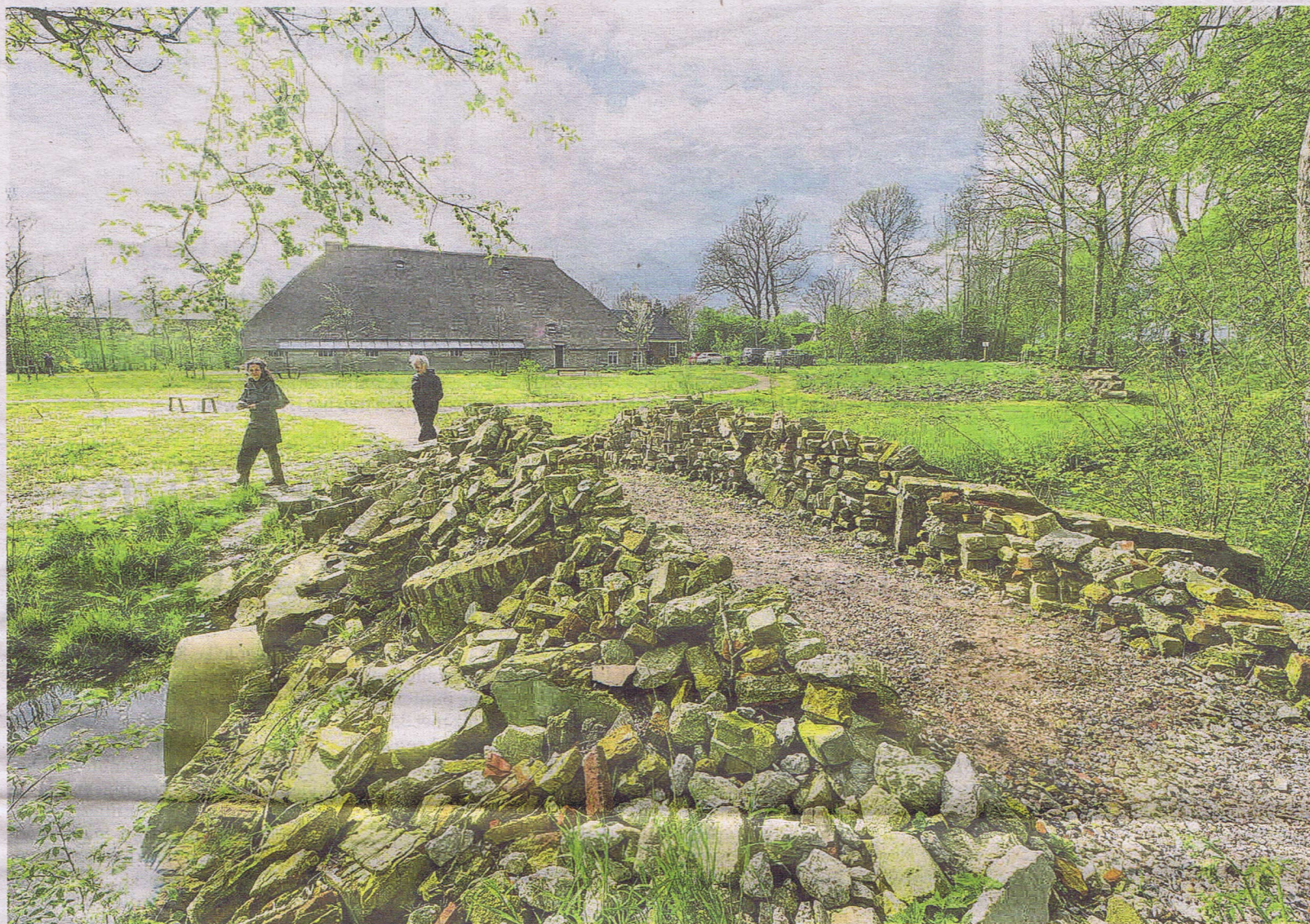
De brug is gebouwd met stenen die bij de restauratie van de boerderij zijn vrijgekomen. De natuur moet de brug uiteindelijk in bezit nemen. FOTO'S: MARCEL VAN KAMMEN
